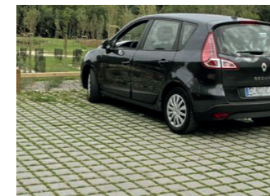
Pavés engazonnés ou à joints sable infiltrant
