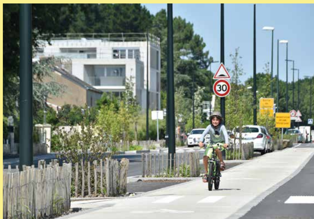
Après 11 mois de travaux, la route de Carquefou a été livrée en novembre 2020.
