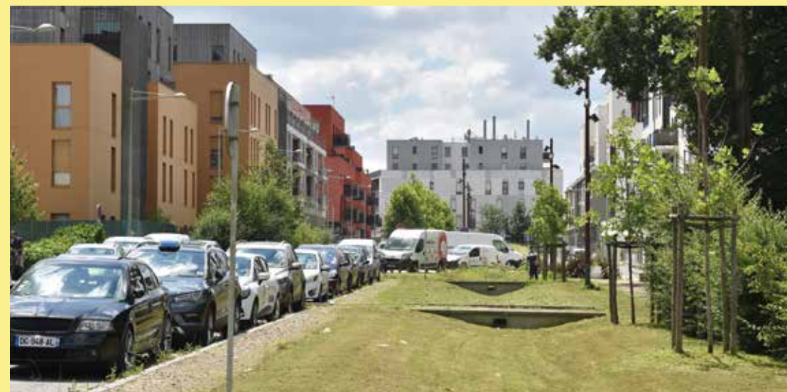
Une noue est un fossé végétalisé large et peu profond qui permet de recueillir l'eau, soit pour l'évaporer, soit pour l'infiltrer sur place.
