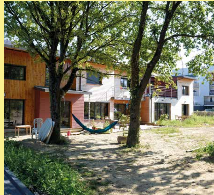
Sur un terrain de 3 000 m 2 , 9 familles, réunies en association, ont construit 10 maisons individuelles groupées, économes en énergie, avec un jardin, un parking souterrain mutualisé, et une maison commune pour accueillir les fêtes entre voisins et les proches en visite. Le premier exemple d'habitat participatif sur le quartier.
